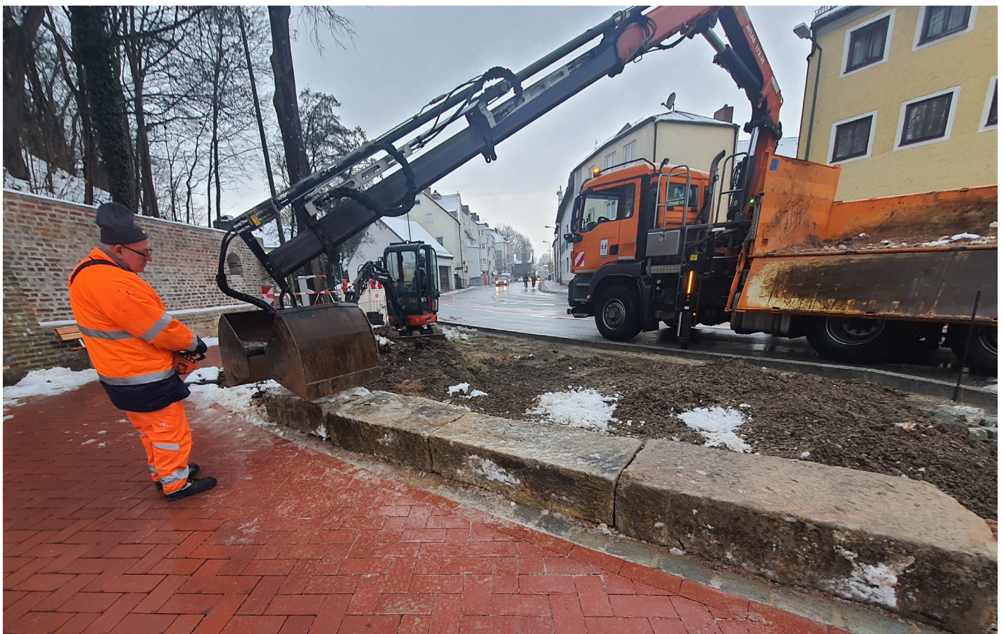
Abbildung 30 : Der Bauhof setzt die letzten schweren Steine drei Tage vor Weihnachten, 21. Dezember 2022
