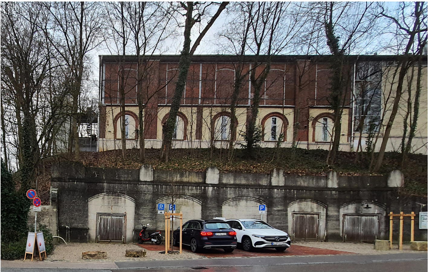
Abbildung 29 : Entsiegelte Parkplätze und Sitzbereiche bei den Eiskellern, Februar 2023
