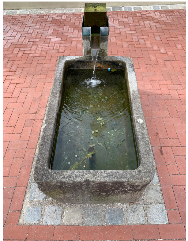
Abbildung 11 : Einfassung Bestandsbrunnen aus gebrauchtes Granitpflaster
