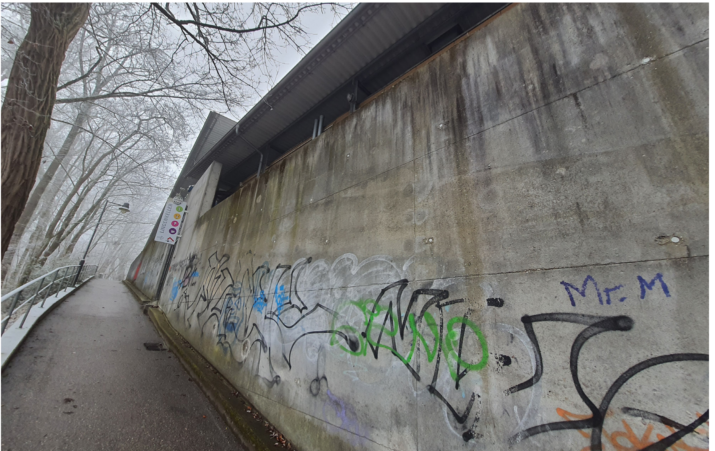
Abbildung 24 : Foto Betonwand, Winter 2022
